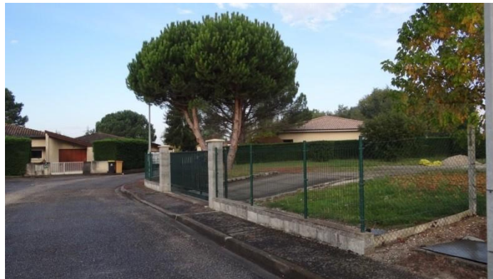
La cité RTE à proximité du poste électrique de Cubnezais
