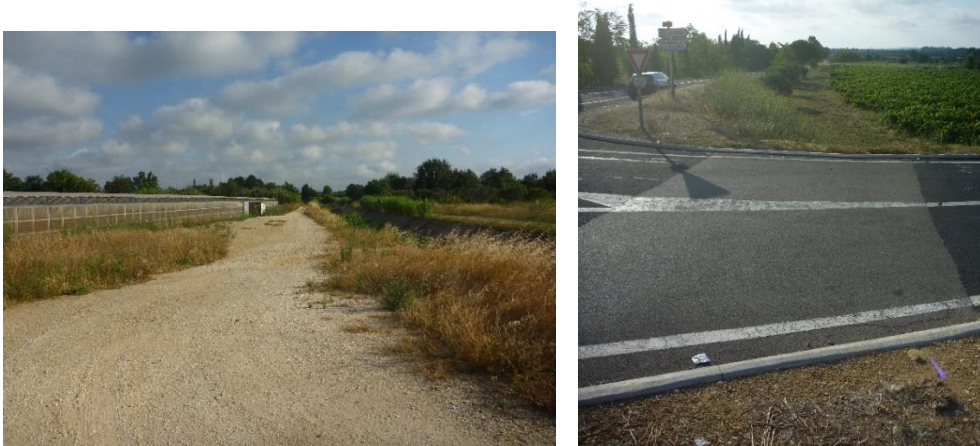
Photos de la liaison Baixas – Santa Llogaïa après travaux
