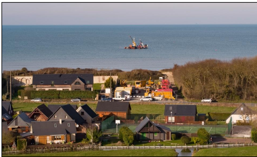
Exemple d'un chantier du forage dirigé sous la dune du projet France– Grande-Bretagne (IFA2) - Source : RTE
